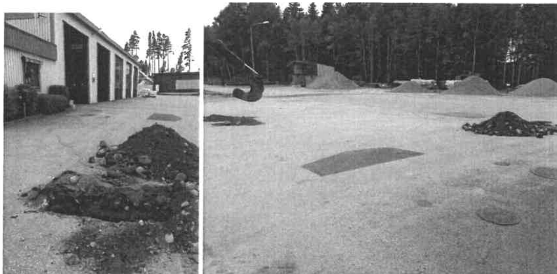
Figur 7. Foton från provgroppgrävningen 2013-07-09. Provgrop norr/nordväst om oljeavskiljare (t.v.) samt vy över de båda provtagningspunkterna MSm7 och MSm8 samt oljeavskiljare och tidigare provgrop MSm3 (t.h.) (Foto: ÅF 2013)
